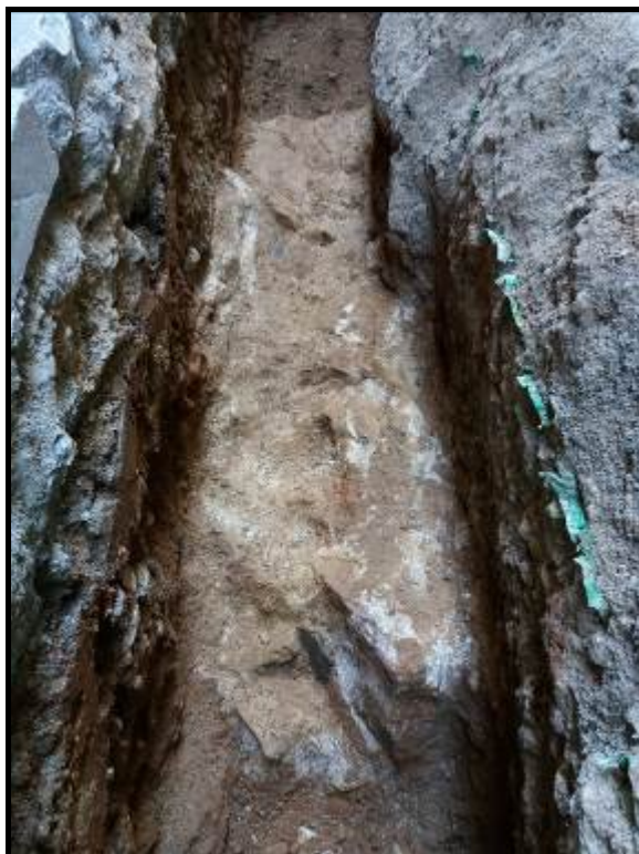
Fotografia 3. Detall del mur U.E.05, localitzat durant els treballs.
