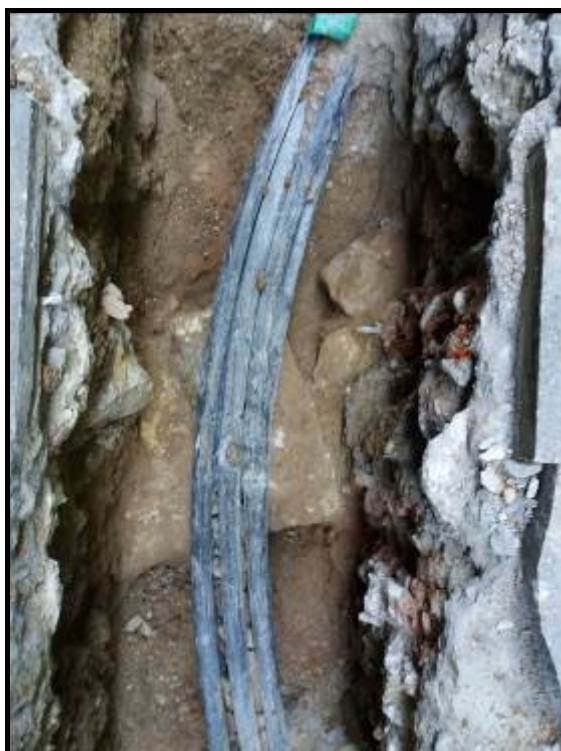
Fotografia 4. Detall del mur U.E.06, localitzat durant els treballs
