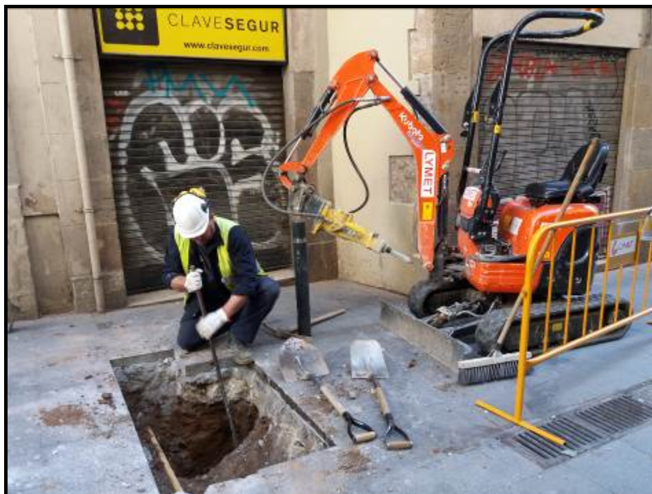
Fotografia 5. Tasques d'obertura manual i a màquina de la rasa.
