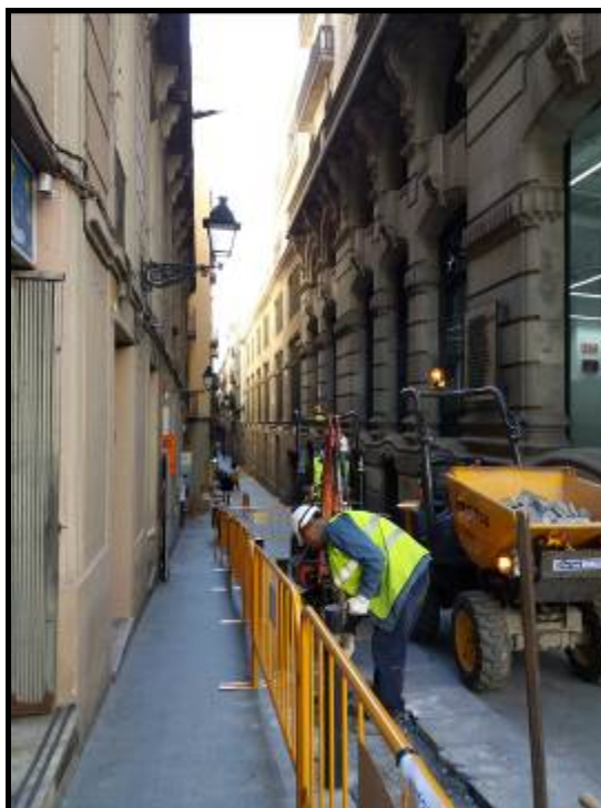
Fotografia 1. Detall del carrer d'Estruc abans de començar els treballs.
